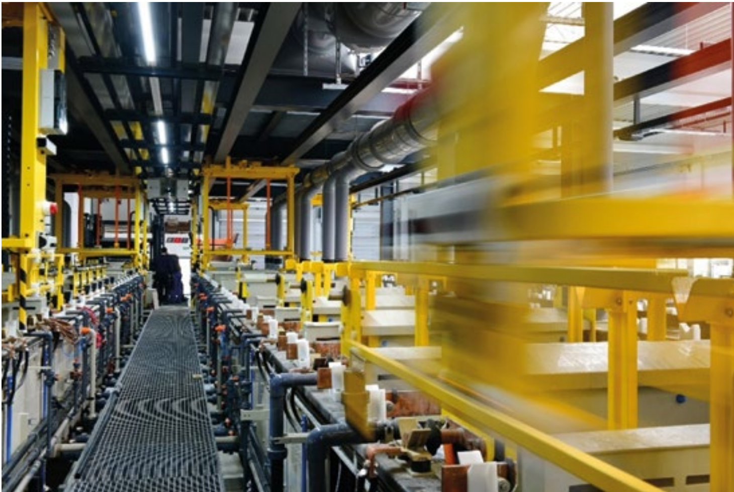
Bild: B+T Oberflächentechnik GmbH
