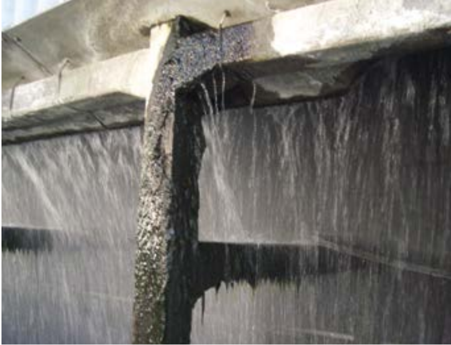
Abb. 3: Biofilm am und im Rückkühlwerk
