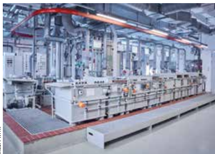
Abbildung 5: Technikum bei Hillebrand Chemicals
