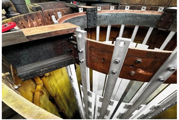
Anfang 2023 wurden bei der Wilhelm Bauer GmbH & Co. KG maßgeschneiderte Anoden mit einer beeindruckenden Länge von über sechs Metern installiert.
