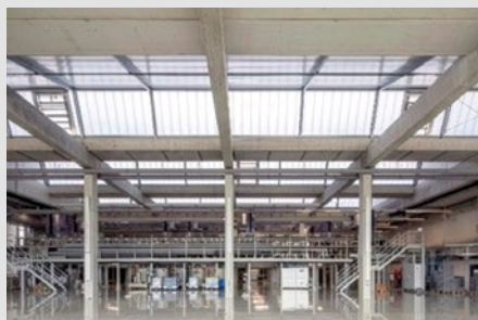
Oberflächenanlage von METZKA
