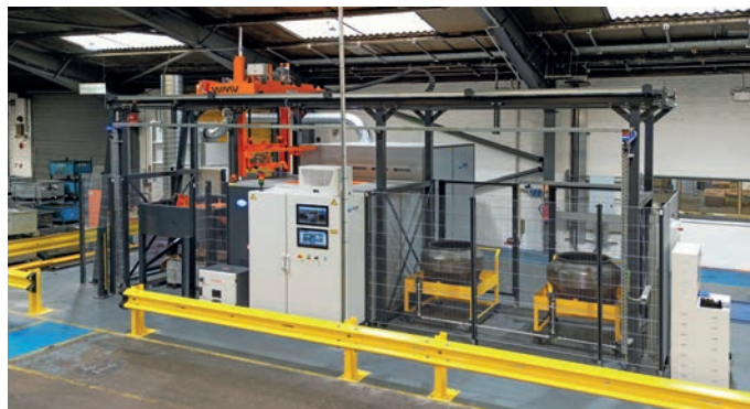
Abb. 6: Die Anlage im Werk in Großbritannien
