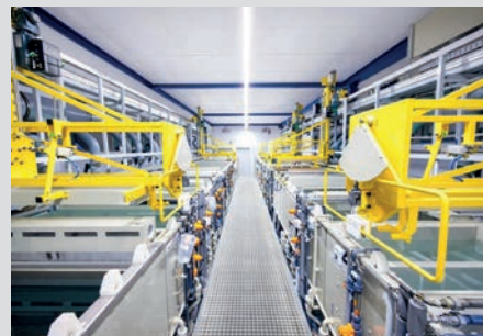
Die neue Galvanikanlage bei SAXONIA
